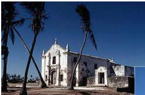
Our Lady of the Bulwark Ilha de Moçambique (1522)
